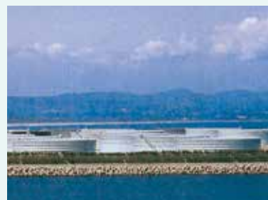
国家石油備蓄基地
